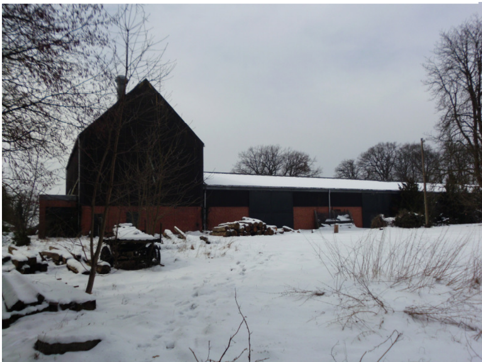
Foto Nr. 4: Blick auf die Halle mit Speicher (Abriss vorgesehen). Aufgrund fehlender Zugangsmöglichkeiten sind hier keine Fledermausquartiere zu erwarten.
