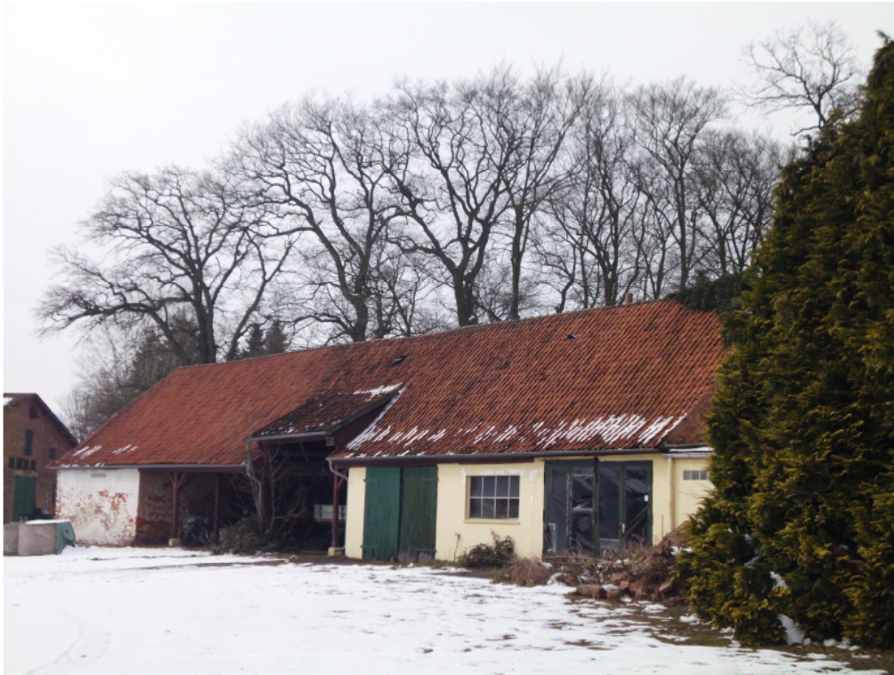
Foto Nr. 5: Auf dem Dachboden dieser alten Scheune (Abschnitt links) befinden sich potenzielle Fledermausquartiere oder evt. ein Eulenversteck.
