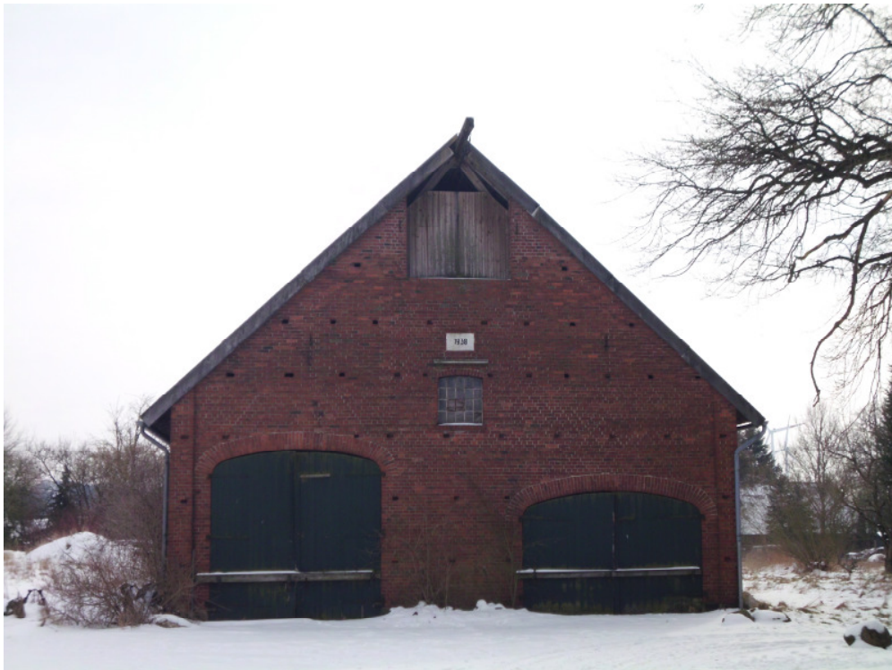
Foto Nr. 6: Dieses ehemalige Stallgebäude bietet viele Möglichkeiten für ein potenzielles Fledermausquartier. Auch für Eulenarten bestehen über die Giebelöffnung Zugangsmöglichkeiten auf den Dachboden.
