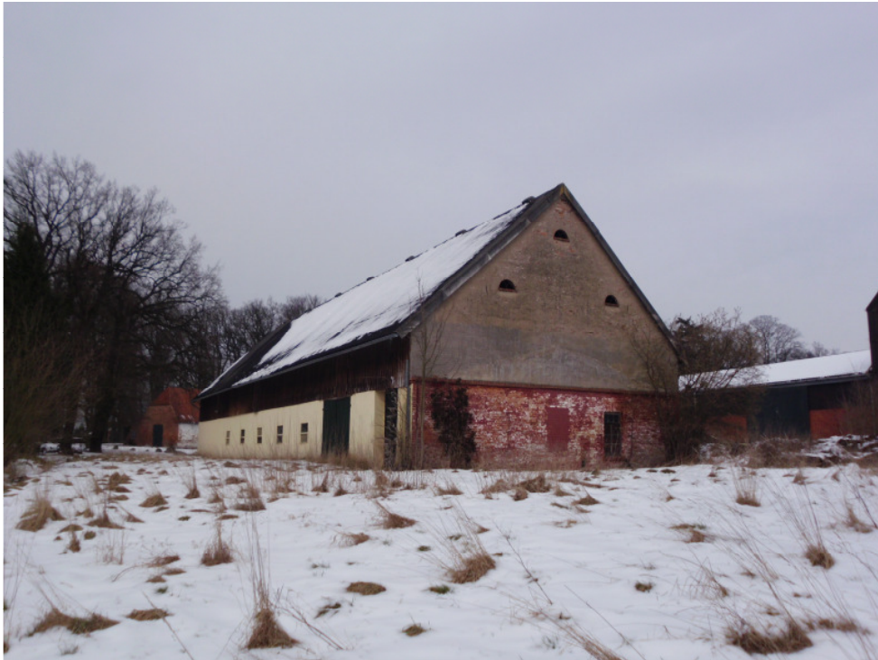
Foto Nr. 7: Blick auf die Süd- und Westseite der Scheune (Foto Nr. 6) mit davorliegender Brachfläche. Durch die teilweise eingeschlagenen Stallfenster bestehen gute Einflugmöglichkeiten in das Gebäudeinnere.
