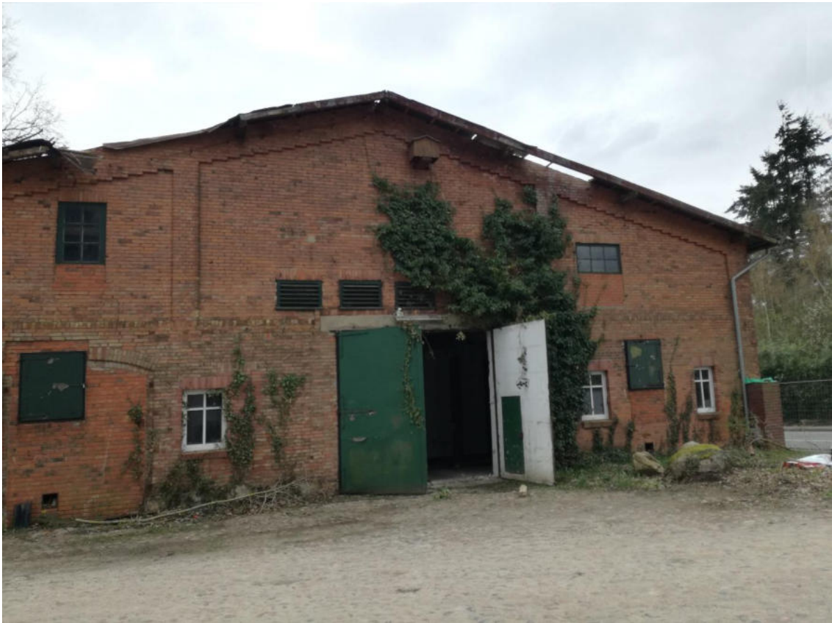
Abb. 2: Leerstehende Halle an der Dorfstraße, Blickrichtung Süden
